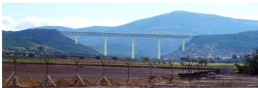
Figura 9 - Viadotto M'Dig Tlemcen della ferrovia AV Oued Tlelat - Tlemcen
