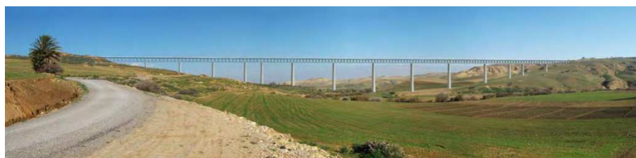
Figura 10 - Viadotto Oued Isser della ferrovia AV Oued Tlelat - Tlemcen
