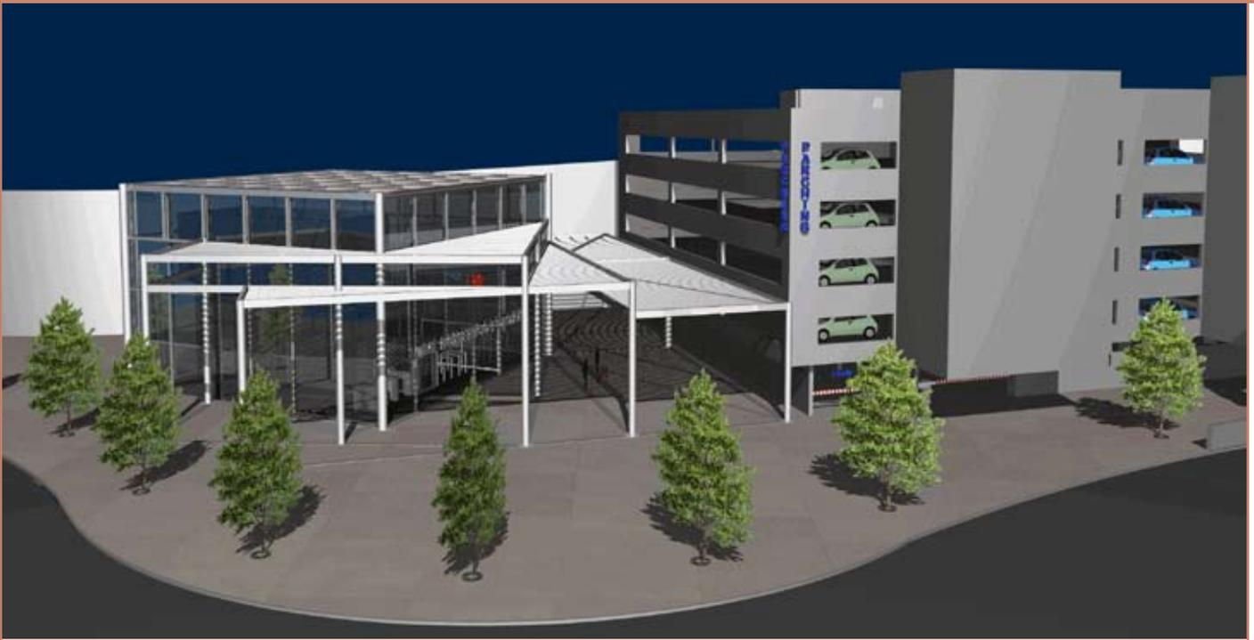
co Fontana è prevista la realizzazione di una nuova stazione *ad hoc*, adiacente alla quale, al fine di agevolare l'interscambio modale è prevista la realizzazione di un parcheggio multipiano ad elevata automatizzazione (**Figura 6**).
